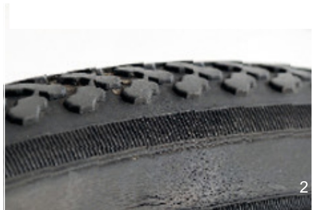
Figura 120: Ejemplos de fisuras por fatiga (1) y fisuras por envejecimiento (2)
